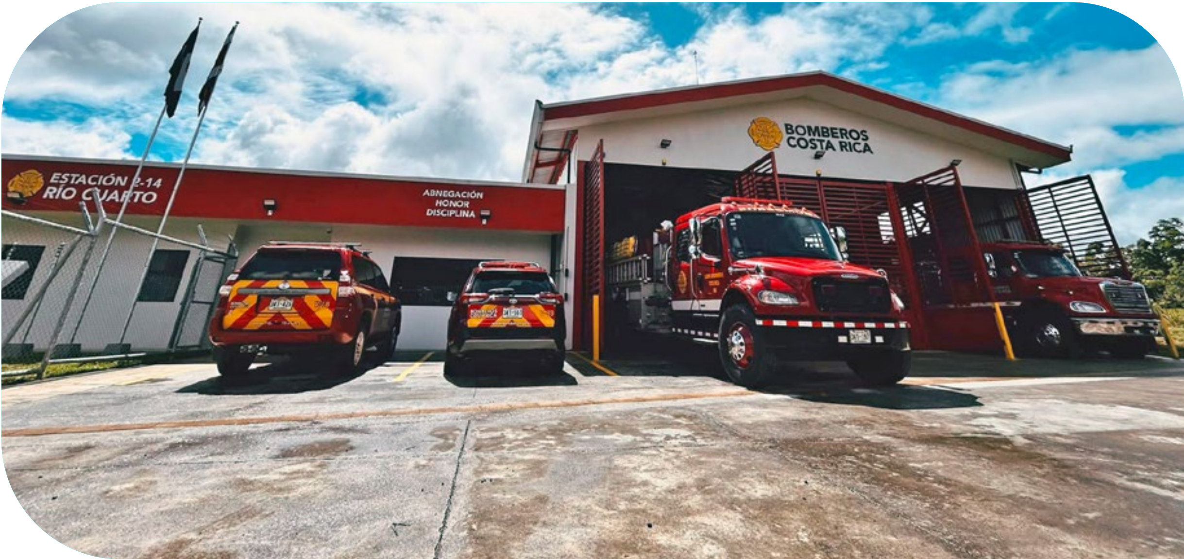
Fotografía: Estación de Bomberos de Río Cuarto
